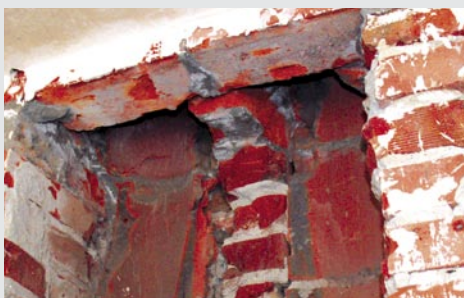
Na tylnej ścianie kanałów widoczne pozostałości po kształtkach ceramicznych.
